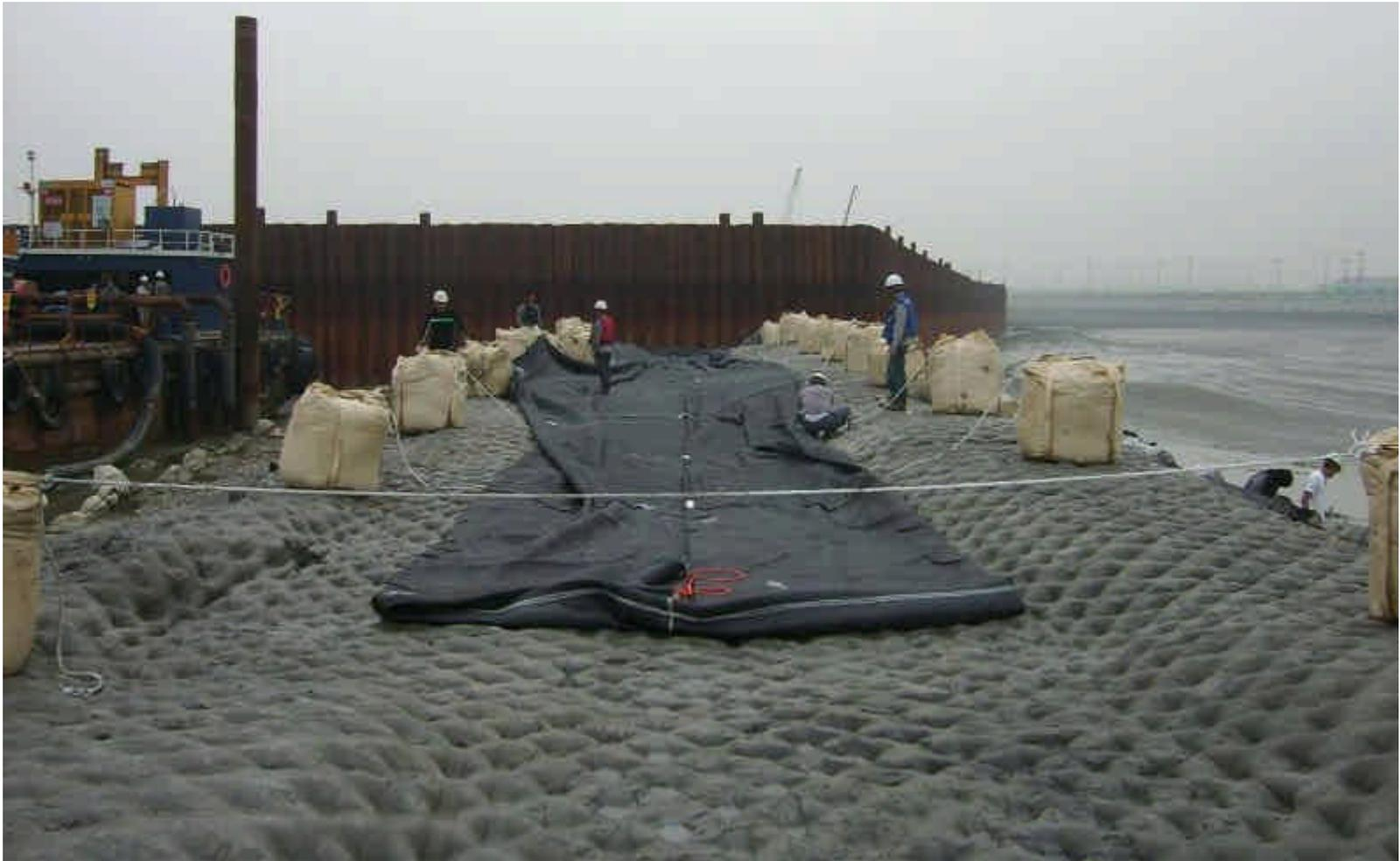
Laying 2<sup>nd</sup> level Geotube<sup>®</sup> above sand mat
